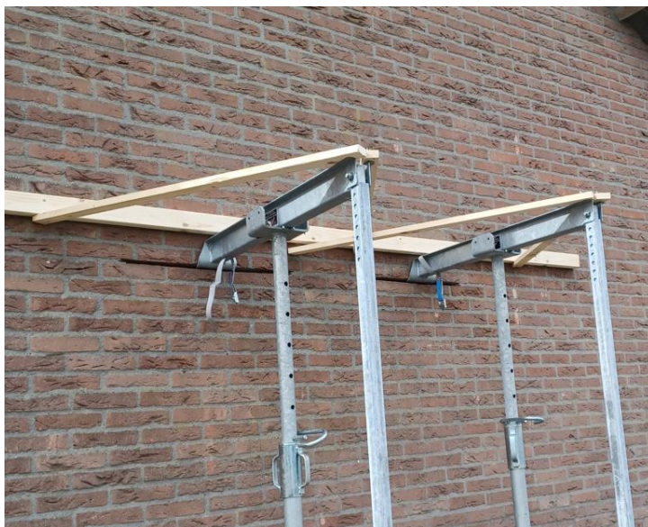
Figuur 9: Weergave van schoren van de Stut Alone
